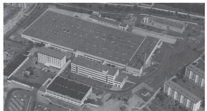
Bild 15: Die Reinraumfabrik in Meiningen (90 m x 240 m)
