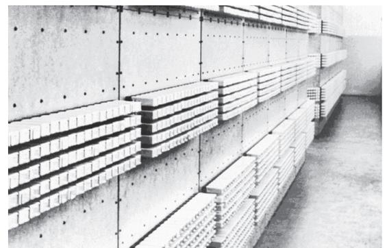
Bild 7: Rückseite der Anlage OPREMA mit den in 100er-Blöcken angeordneten Relais. Man erkennt die Struktur der geplanten Zwillinganlage
