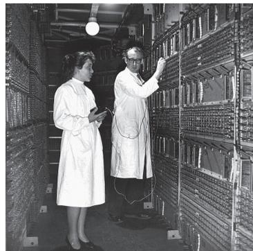
Bild 6: Fehlersuche im Rechenautomaten OPREMA im VEB Carl Zeiss Jena 1954
