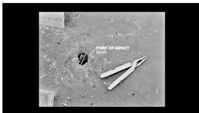
Abbildung 2: Einschlag des Drohnen-Geschosses im Hausdach, bevor es im Inneren explodierte
