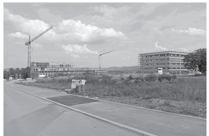
Baustelle Obere Viehweide – Quelle: IMI
