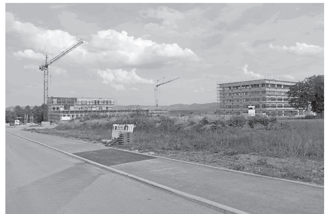
Baustelle Obere Viehweide – Quelle: IMI
