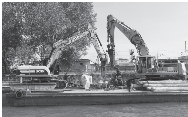
Bei epicenter.works wird gebaut.
